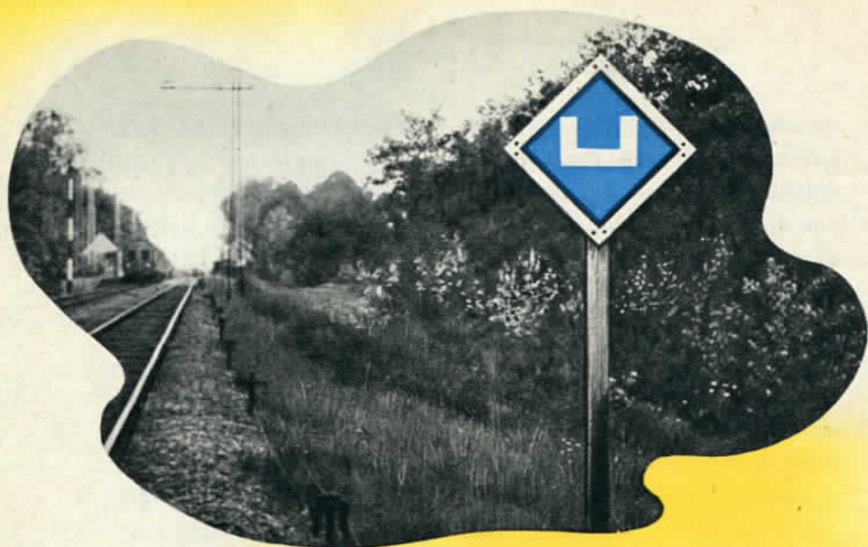
Seinen voor electrische treinen... De gesloten U beteekent inschakelen
