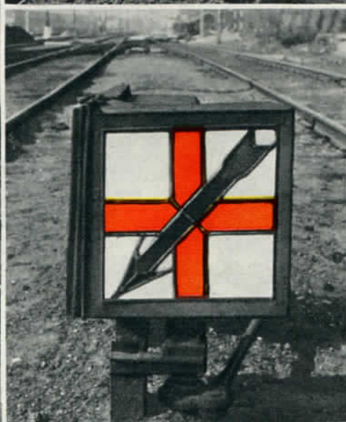
Rangeerstoplantaren boven: „veilig” onder: „onveilig” De pijl wijst het spoor aan waarvoor de lantaren geldt.
